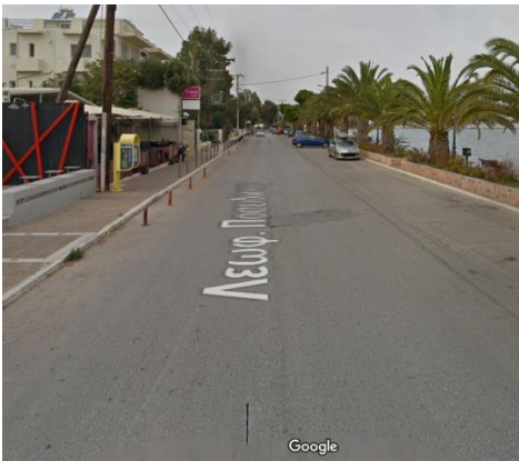
Εικόνα 3: Υφιστάμενη κατάσταση στη συμβολή Λ. Ποσειδώνος/Ελ. Βενιζέλου - Αφετηρία προτεινόμενης πεζοδρόμησης.
