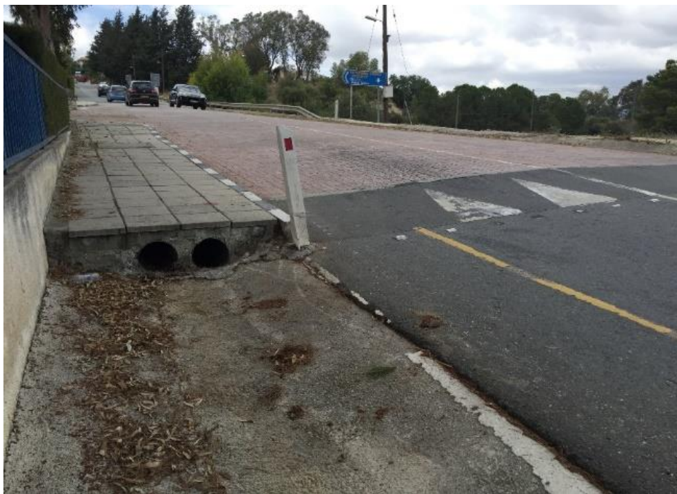
Εικόνα 20: Πλατό οδοστρώματος στην Κύπρο.
