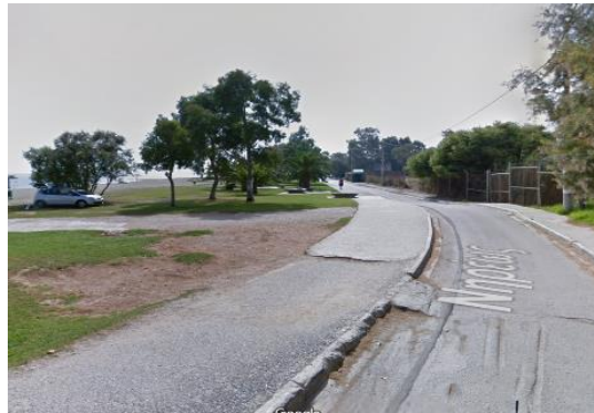
Εικόνα 8: Υφιστάμενη κατάσταση της οδού Νηρέως – Πέρας προτεινόμενης μετατροπής (αντίθετη λήψη).
