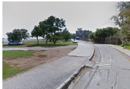
Εικόνα 7: Υφιστάμενη κατάσταση της οδού Νηρέως – Πέρας προτεινόμενης μετατροπής (αντίθετη λήψη).
