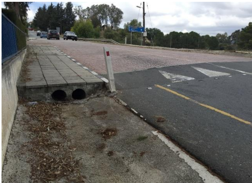
Εικόνα 8: Πλατό οδοστρώματος στην Κύπρο.
