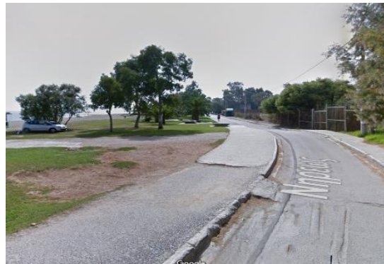
Εικόνα 14: Υφιστάμενη κατάσταση της οδού Νηρέως – Πέρασ προτεινόμενης παρέμβασης (αντίθετη λήψη).
